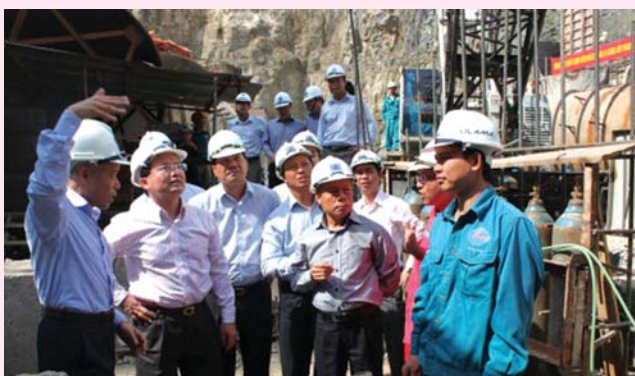
Lãnh đạo Tập đoàn Dầu khí Việt Nam kiểm tra thi công khu vực Nhà máy. Ảnh: PV Power
